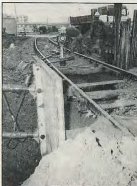
Aménagement. Construction d'égouts pour eaux usées et pluvieuses. Passage sous voie ferrée à proximité de la CM.
