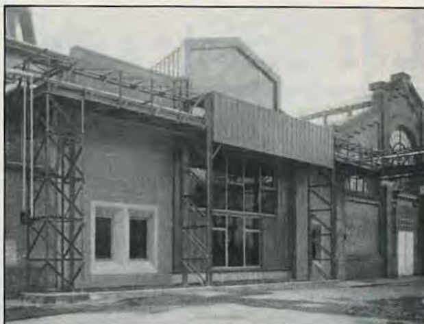
Service FEM. Jonction des bâtiments 121 et 172. Façade Nord réalisée en briques rouges comme les bâtiments adjacents.
